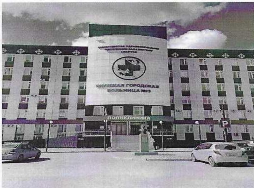
Наружный вид ГАУ РС(Я) «Якутская городская больница №3»
